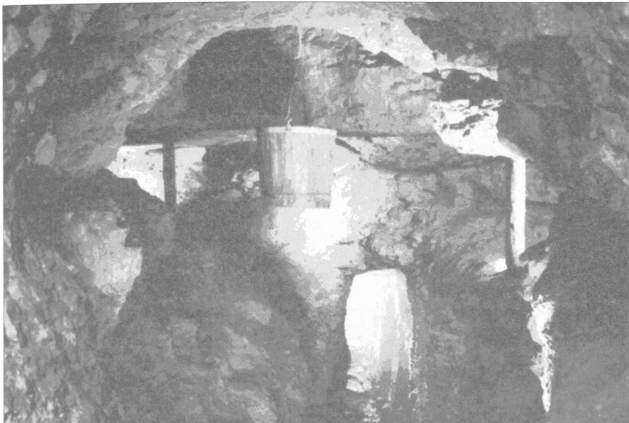
Rycina 1. Podszybie szybu „Szczęść Boże” z zawieszonym kubłem wyciągowym (Kopalnia Zabytkowa w Tarnowskich Górach)
