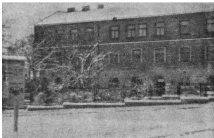
Fot. 7-8. Budynek szkoły powszechnej i gimnazjum hebrajskiego „Safa Berura” w Tarnobrzegu przy ul. Św. Anny 34
