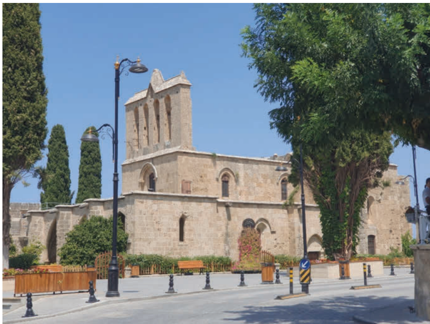
Fig. 30. Pozostałości opactwa Bellapais
