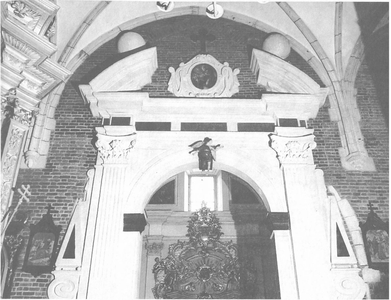
3. Górna część portalu (fot. J. Kozina).
